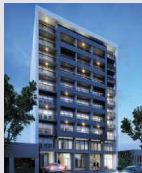
WE BUILDING Av. Pellegrini 4041. Rosario.
