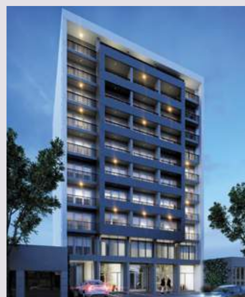
WE BUILDING Av. Pellegrini 4041. Rosario.
